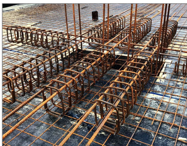
Figura 1.2 – Alternativas construtivas para armadura de punção do tipo estribo.
