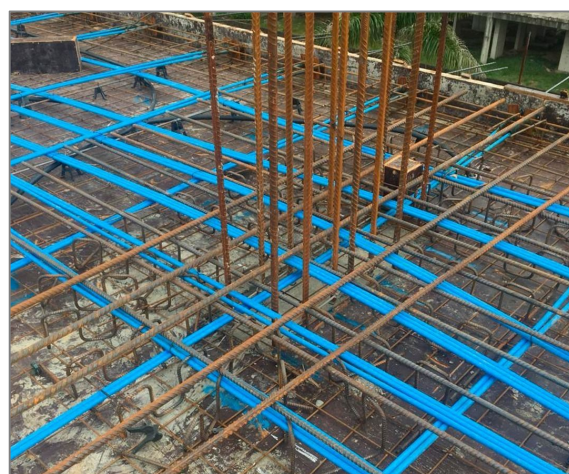
Figura 1.2 – Alternativas construtivas para armadura de punção do tipo estribo.
